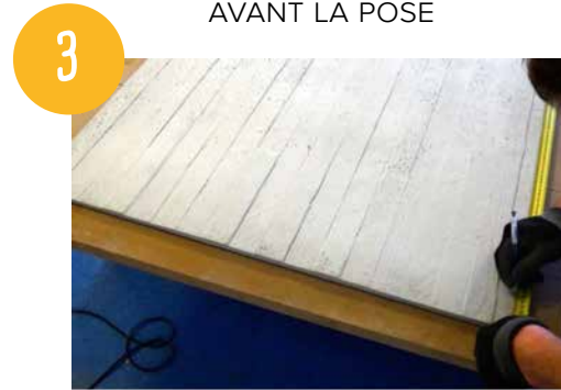
APPLIQUER LES MESURES SUR LE PANNEAU
