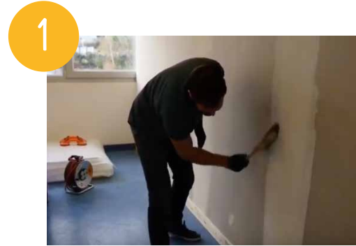
BIEN NETTOYER LA ZONE AVANT LA POSE
