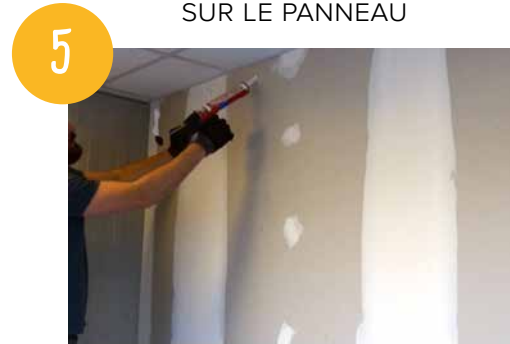
APPLIQUER LA COLLE AU MUR (OU AU DOS DU PANNEAU)
